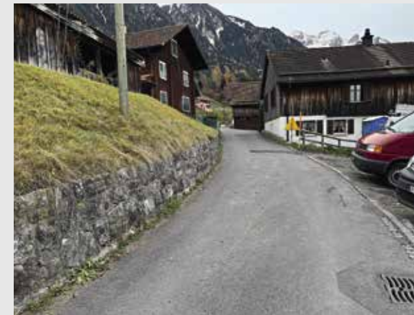
Die dringend nötige Sanierung der Guferstrasse hat bereits im Frühling 2023 begonnen.
