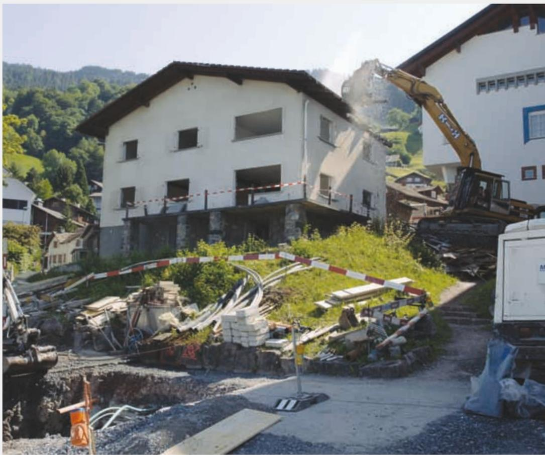
**TIEFBAUARBEITEN DAUERN DEN GANZEN HERBST** In den letzten Tagen wurden nun die umfangreichen und aufwändigen Tiefbauarbeiten für das Vereinshaus in Angriff genommen. Zur Sicherung der Baugrube und der umliegenden Gebäude sind etliche Bohrpfähle und Verankerungen not-
