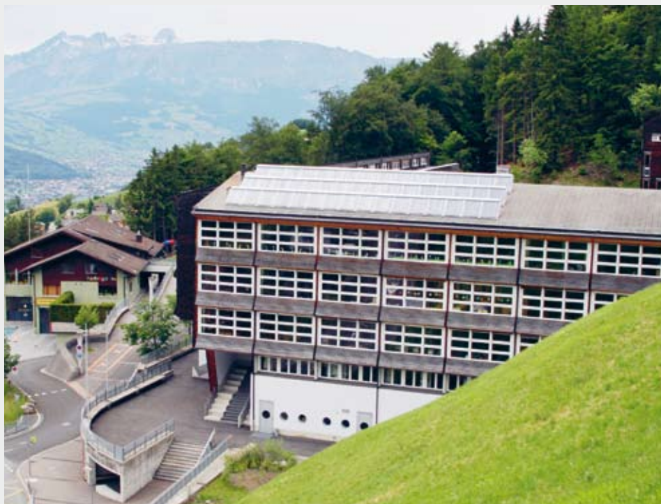
Die Tagesstrukturen könnten in Räumlichkeiten der Primarschule oder daneben im Kinderkartengebäude untergebracht werden
