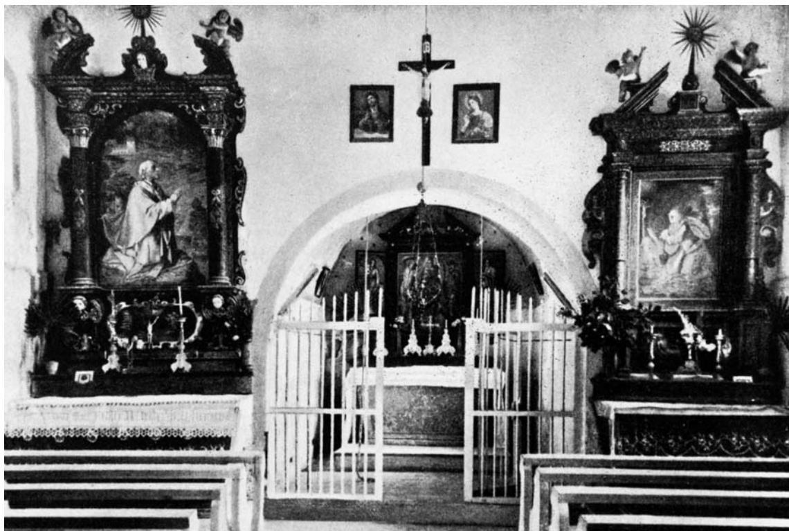
Die Kapelle vor der Renovierung 1950
