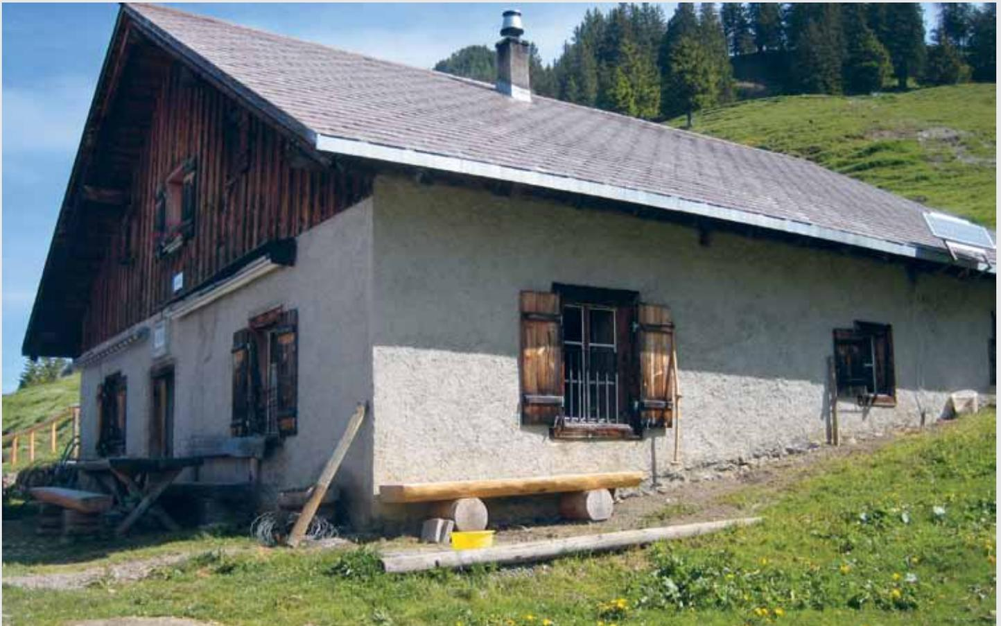
Nachdem auch die Wasserversorgung für die 1932 erbaute Alphütte verbessert wurde, sollen im Zuge der Renovationsarbeiten sanitäre Einrichtungen (Dusche/WC) eingebaut, die Innenräume samt Küche erneuert und das Dach isoliert werden.
