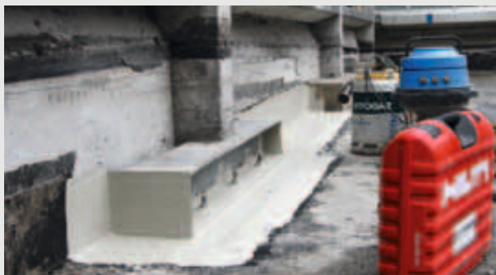
Details wurden sauber und korrekt ausgeführt.
