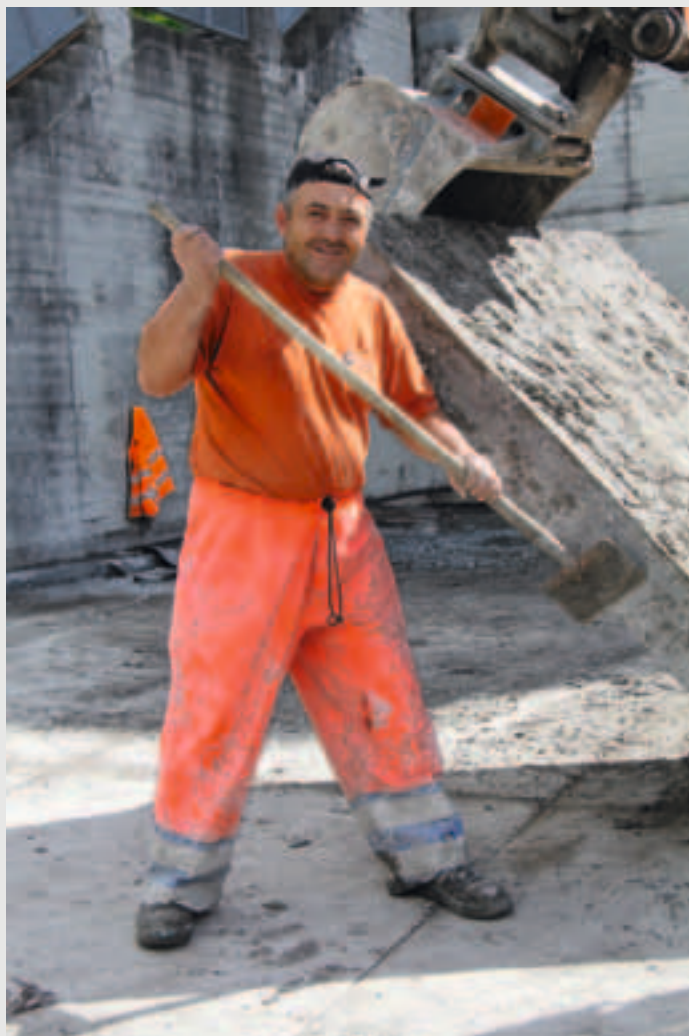
Die orangefarbene Wolfinbahn musste von den Betonteilen abgekratzt werden.
