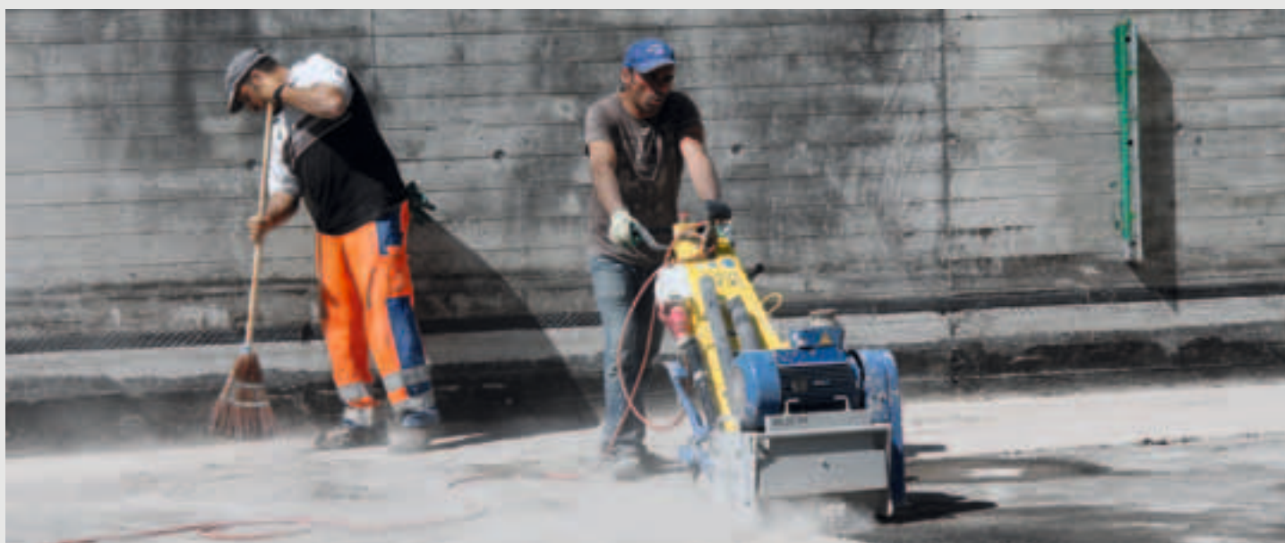
Der alte Teerbelag musste Meter für Meter abgeschliffen werden.
