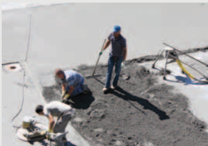
Einbau der neuen Zementschicht.
