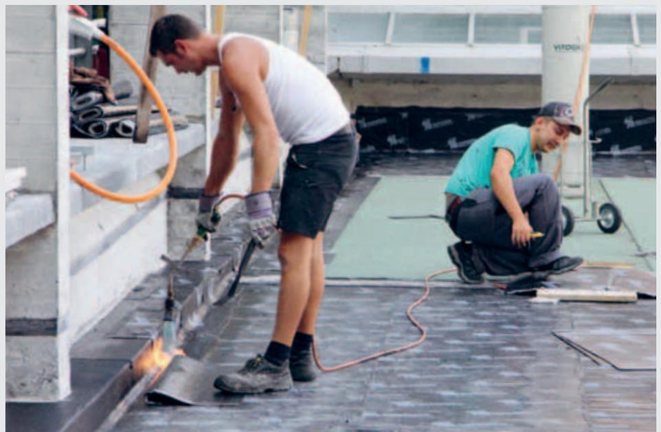
Sorgfältig wird die zweilagige bituminöse Wasserisolation verlegt
