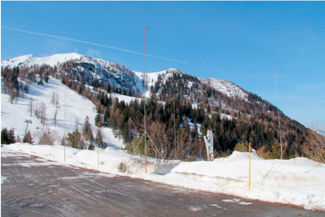
Die Bauprofile für das Heizwerk Malbun stehen.
