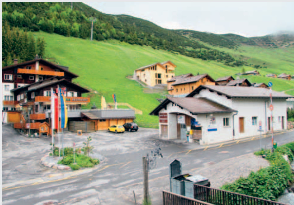
Der Untergrund der Kreiselfläche und die Parzelle mit der Sesselbahnanlage und dem Talstationsgebäude der Bergbahnen Malbun AG sind neu im Besitz der Gemeinde.
