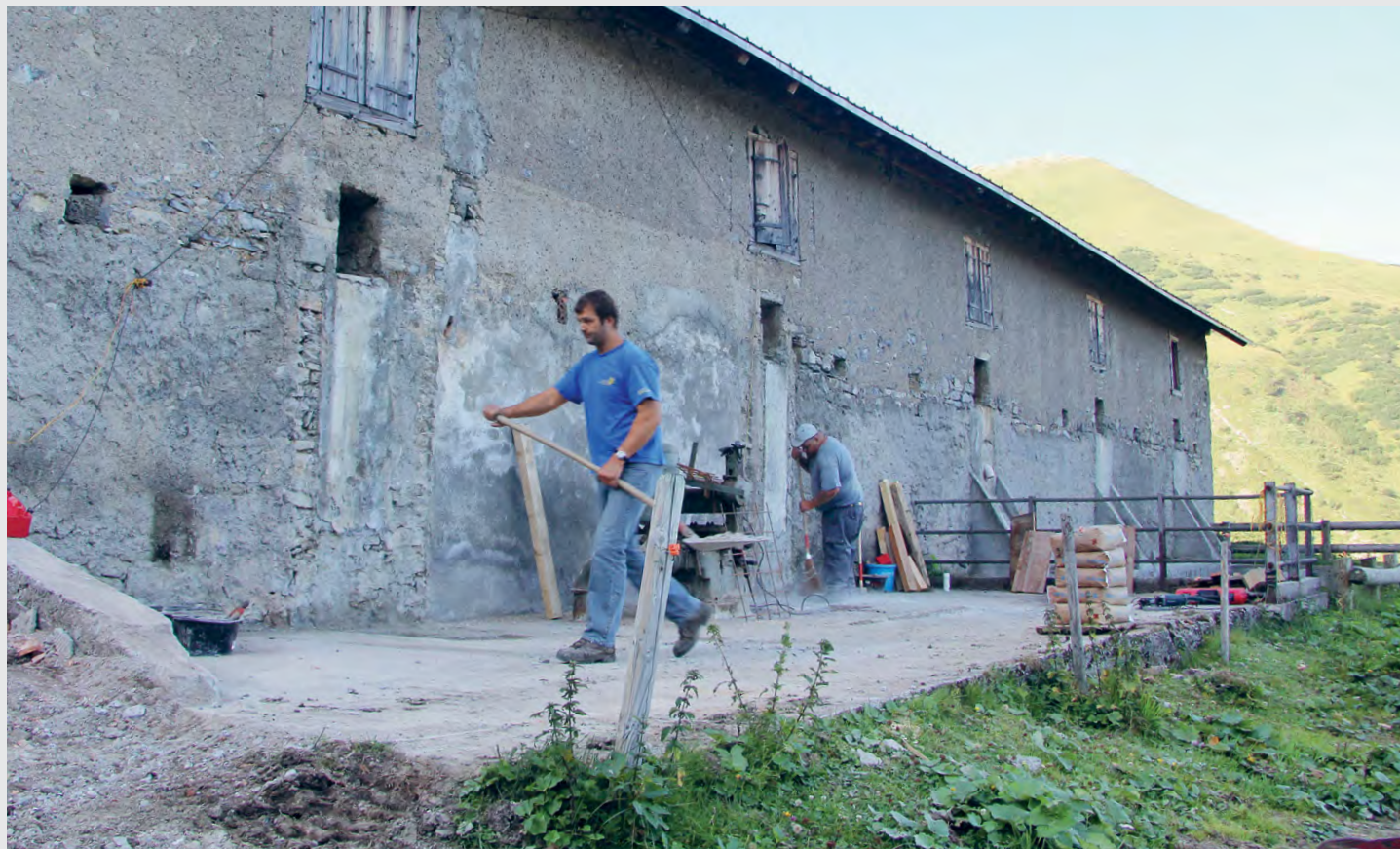
Fidel Beck und Markus Schädler bei Aufräumarbeiten vor dem Stallgebäude nachdem der Anbau für die Güllepumpanlage abgebrochen wurde.
