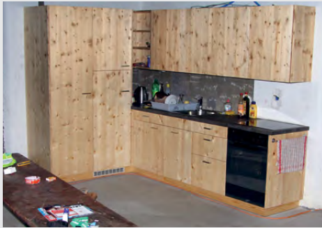
Einfach und zweckmässig erfolgt der Innenausbau.
