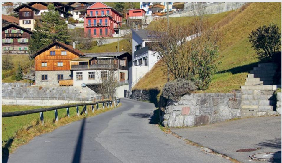
Im Bereich der Kurve im Vordergrund wird die Wangerbergstrasse auf fünf Meter verbreitert.
