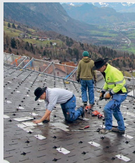
Im April haben Monteure der Liechtensteinischen Kraftwerke die Montage der Photovoltaikanlage vorbereitet.
