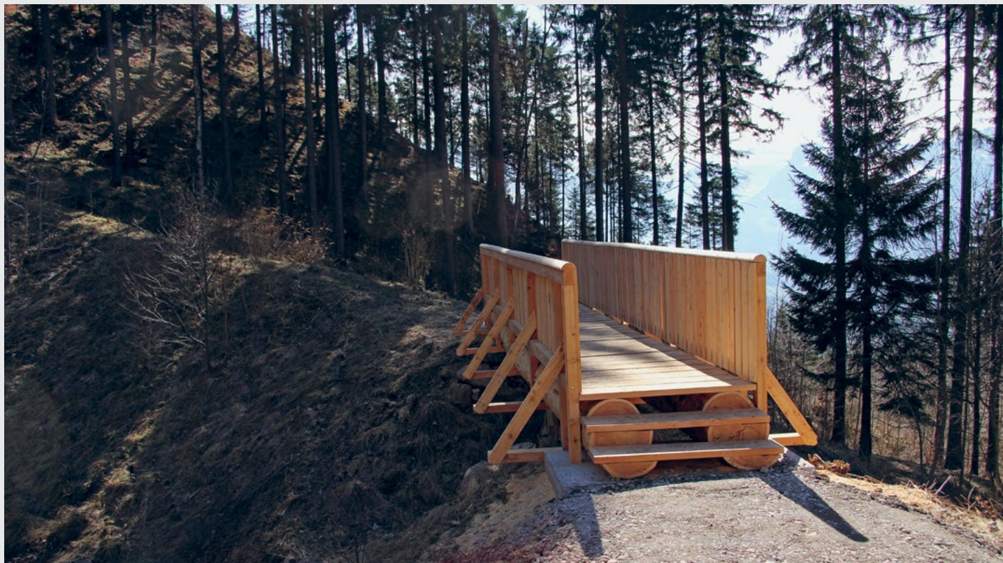
Die neue Brücke über die Rūfeverbauung ist der Startpunkt zur Wegstrecke, die den Ortsteil Burkat mit der Teufistrasse verbindet.
