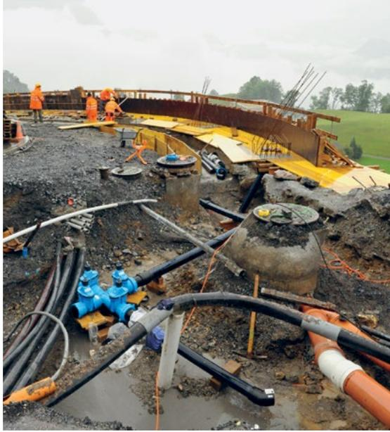
Seit einigen Jahren werden für den Wasserleitungsbau nicht mehr die schweren und zudem rostenden Gussrohre verwendet, sondern leichtere, biegsame Polyäthylen-Kunststoffrohre.
