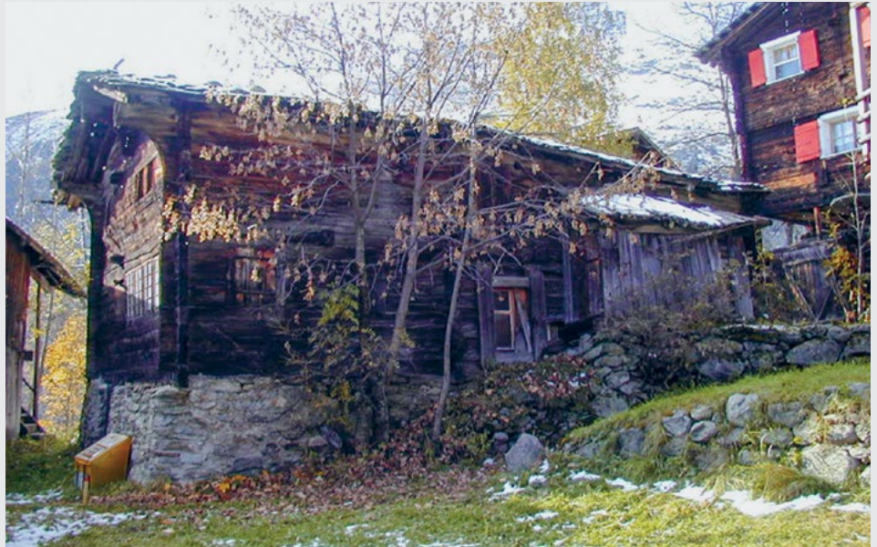
Das Huberhaus in Bellwald, Wallis, vor der Renovation durch die Stiftung Ferien im Baudenkmal.
