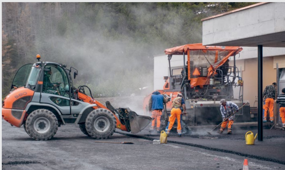
Dank Wetterglück konnten bei Redaktionsschluss am 21. November noch Belagsarbeiten durchgeführt werden.
