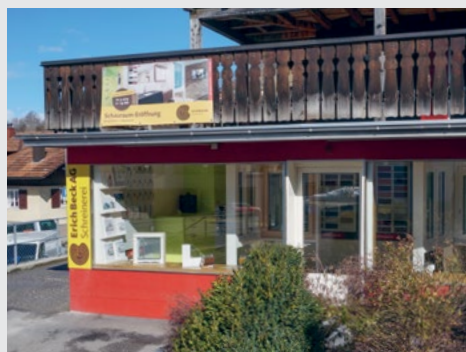
Der Schauraum der Schreinererei Erich Beck AG ist bereits umgebaut.
