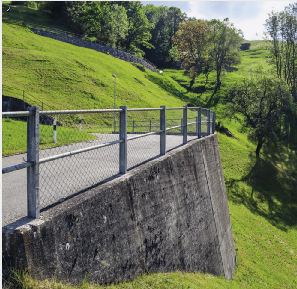
Absturzhöhe von drei Metern, einen Maschendrahtzaun von einem Meter Höhe angebracht. Auch entlang der Landstrassen, wie beispielsweise auf der Egga an der Rotenbodenstrasse, prüft das Tiefbauamt entsprechende Konstruktionen zur Absturzsicherung. Erste konkrete Massnahmen konnten somit umgesetzt werden,
